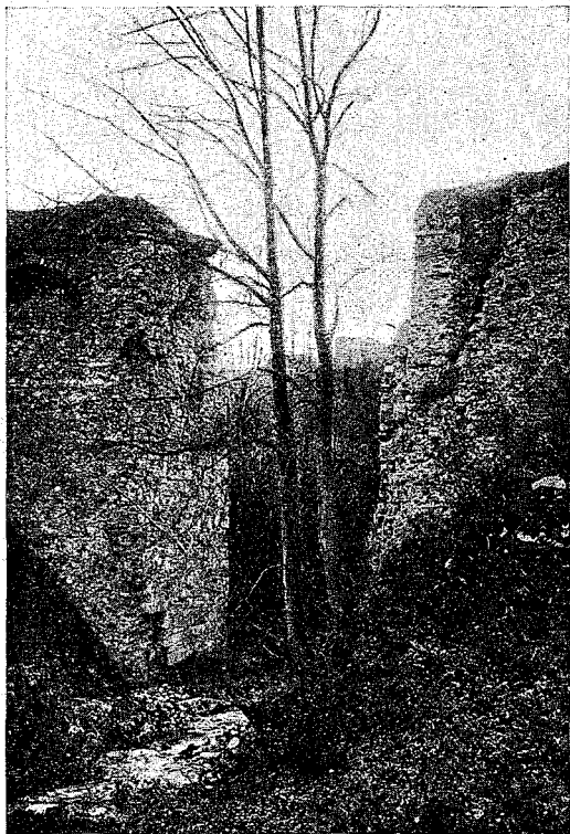
Ruiny wielkiego mostu
